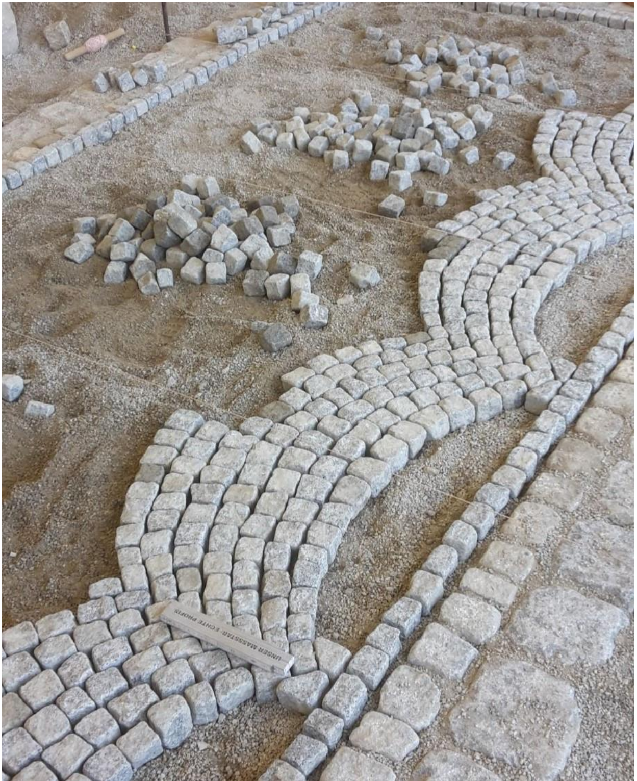
Bildunterschrift: Pflastern von Segmentbögen. Foto: Alexander Sailer, Landratsamt Günzburg
